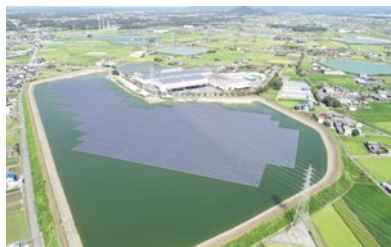
ため池を活用した水上太陽光発電
