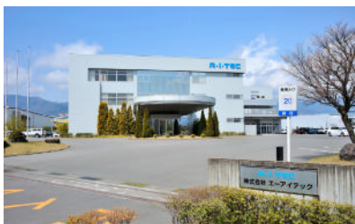
移転拡張した工場
